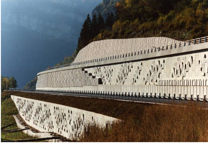
Association d'ouvrages de soutènement ancrés et murs en Terre Armée.
