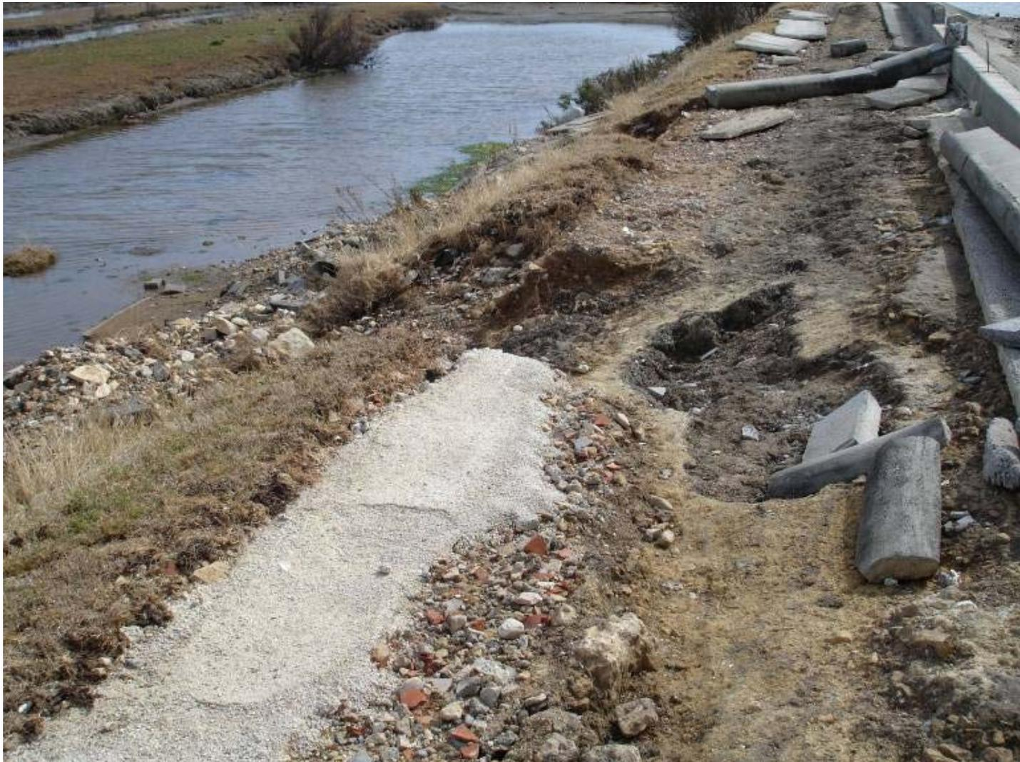
Sur ce site il n'y a pas eu brèche (forte résistance à l'érosion du matériau du corps de digue)
