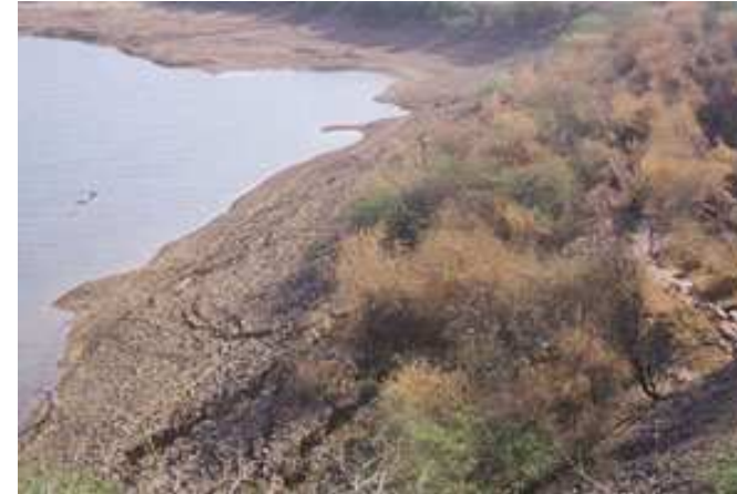
Photo 3.11 : Rupture majeure du corps du barrage. Détail des ruptures côté amont : Avancée du talus et bourrelets émergeant dans le lac.
