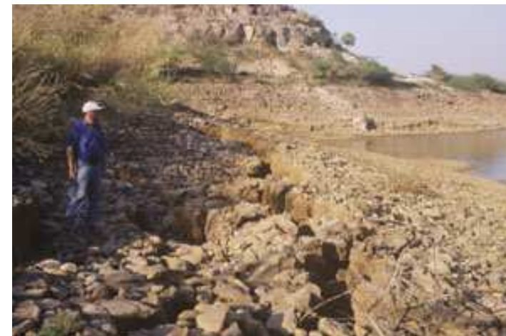
Photo 3.14 : Rupture du talus amont. En arrière plan, chute de bloc et rupture de berge par liquéfaction.
