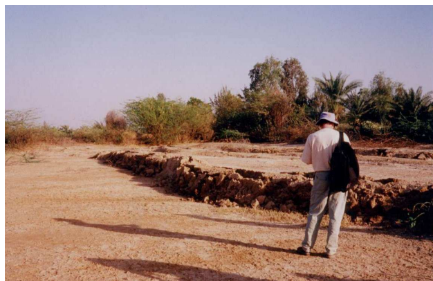
Photo 3.7 : Bourrelet à l'aval d'un glissement horizontal
