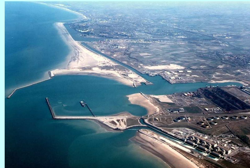
Port Ouest de Dunkerque
