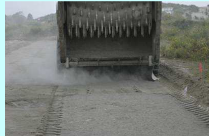
Traitement à la chaux et au ciment
