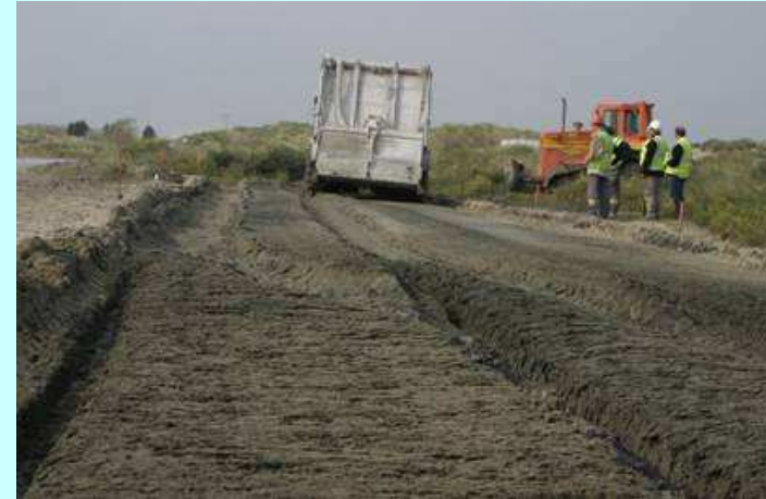
Homogénéisation du mélange sédiments + sable
