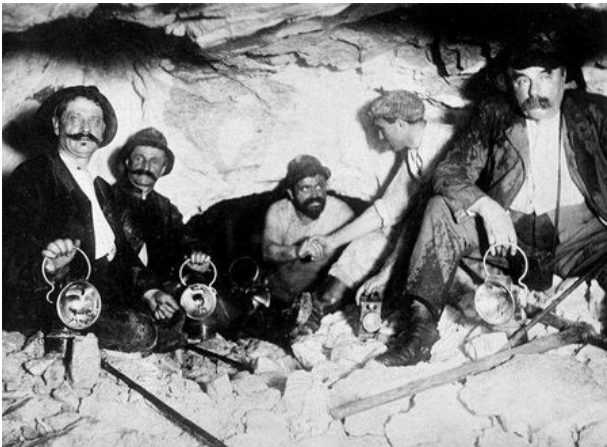
le percement de la galerie de façade du Lötschberg (Suisse), tunnel mis en service en 1913.
