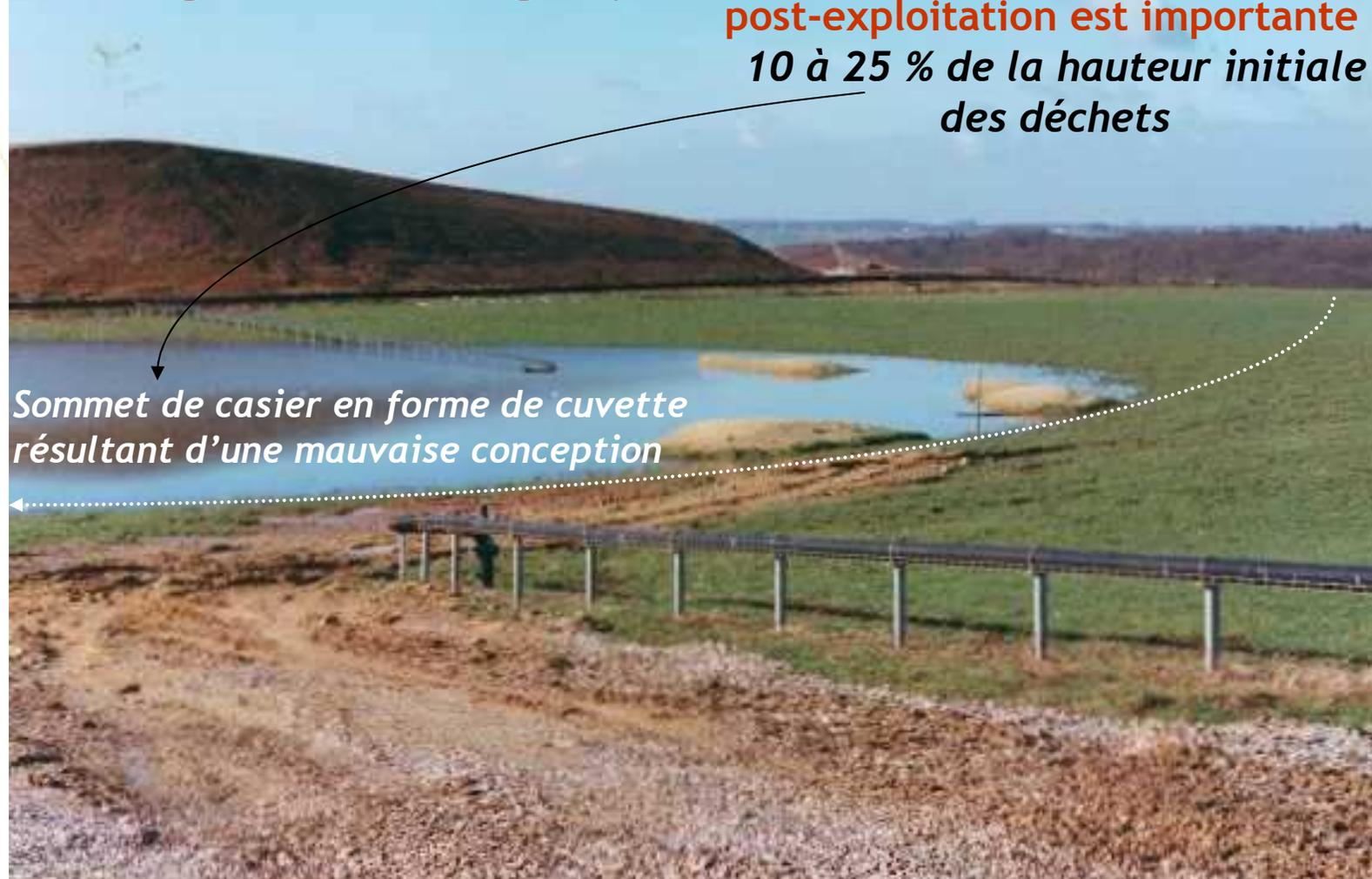
*Sommet de casier en forme de cuvette résultant d'une mauvaise conception*
